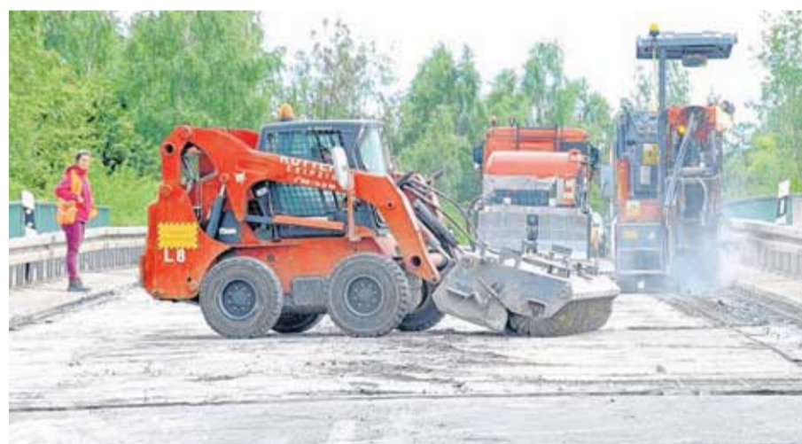
Die Brücke über die Bahnleihe in Neukieritzsch wird derzeit saniert – und sorgt für eine Vollsperrung der B 176 bis zum Ende der Sommerferien. Foto: Thomas Kube
